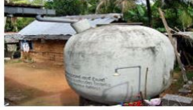
பெரோகிறிட்டுத் தொட்டி (Ferro - crete tank)
